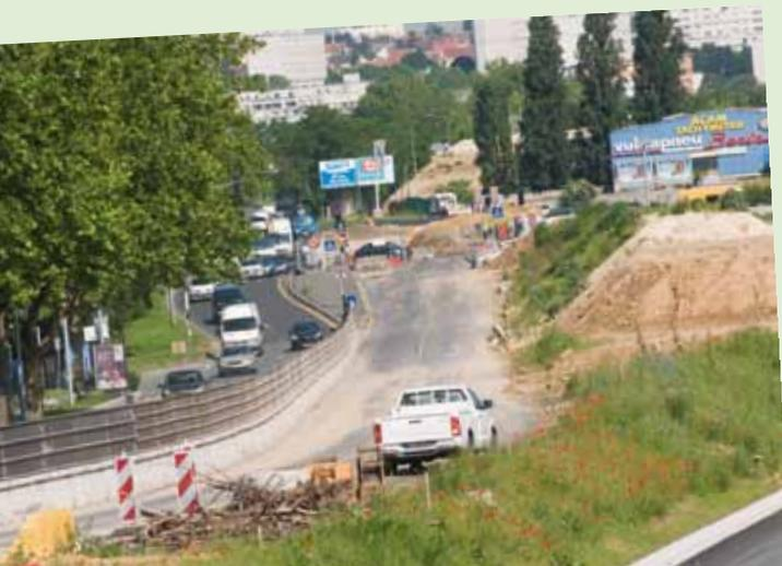
L'ancienne RN19 a été fermée dans le sens de la province vers Paris le jour de l'ouverture de la nouvelle voie vers Paris. Les voies fermées à la circulation seront utilisées comme emprise de chantier pour permettre aux engins d'installer les écrans antibruit sur le talus (à droite de la photo ci-contre).
