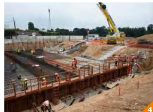
FERRAILLAGE DE LA DALLE DE COUVERTURE AU NIVEAU DE LA RUE DE SUCY.
