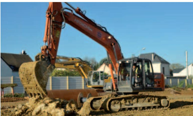
Extraction des blocs calcaires par une pelle mécanique.
