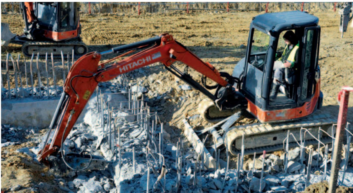
Brise roche hydraulique lors d'une opération de recépage.
