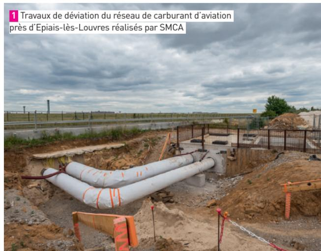
1 Travaux de déviation du réseau de carburant d'aviation près d'Epiais-lès-Louvres réalisés par SMCA
