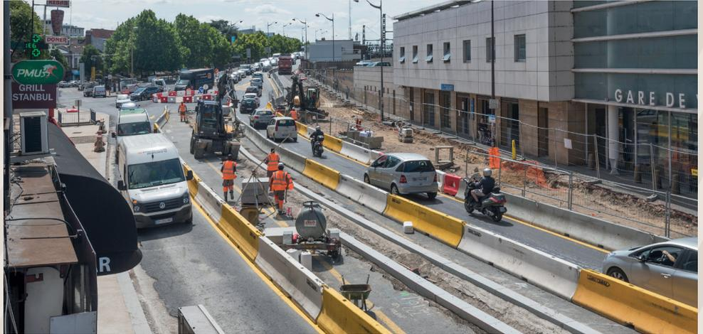
Des travaux de finition ont eu lieu au mois de septembre. Ils concernaient notamment l'implantation de l'éclairage sur le terre-plein central, la réalisation de la chaussée définitive au niveau du giratoire et des passages piétons. Ces travaux ont dû être réalisés de nuit durant les deux dernières semaines de septembre, sous fermeture de l'axe à la circulation.
