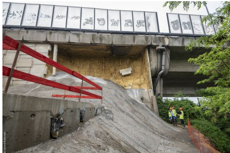
Une couverture provisoire en béton a été construite pour protéger la butte en sablon contre les venues d'eau.
