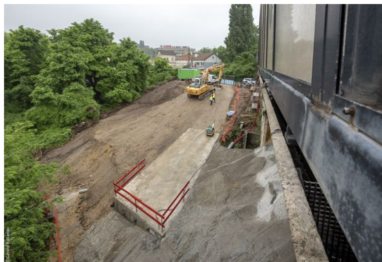
Des plate-formes et des accès aux abords du mur de soutènement ont été construits pour permettre l'intervention d'engins de chantier.
