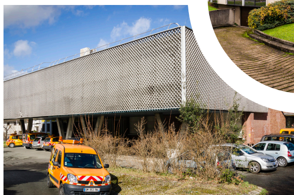
PCTT Sud à Arcueil
