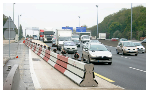
Glissière mobile d'une voie auxiliaire
