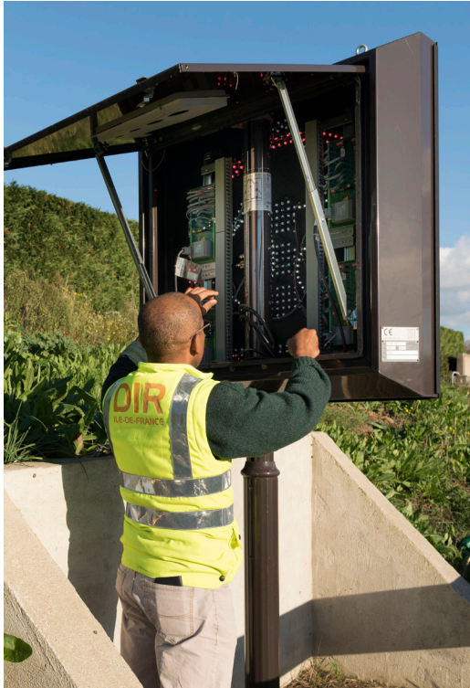
Opération de maintenance d'un panneau à messages variables
