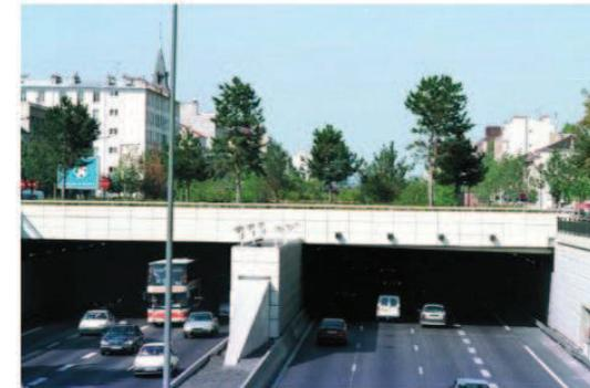
Figure 11 : Exemple de tranchée couverte (source : IQOA Tranchées couvertes, SETRA, mars 2009)
