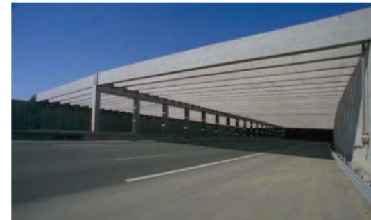
Figure 12 : Exemple de couverture partielle (source : IQOA Tranchées couvertes, SETRA, mars 2009)
