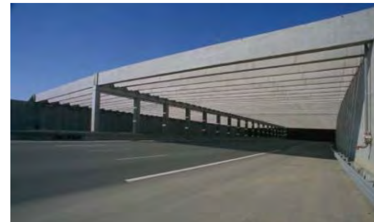
Figure 22 : Exemple de couverture partielle (source : IQOA Tranchées couvertes, SETRA, mars 2009)
