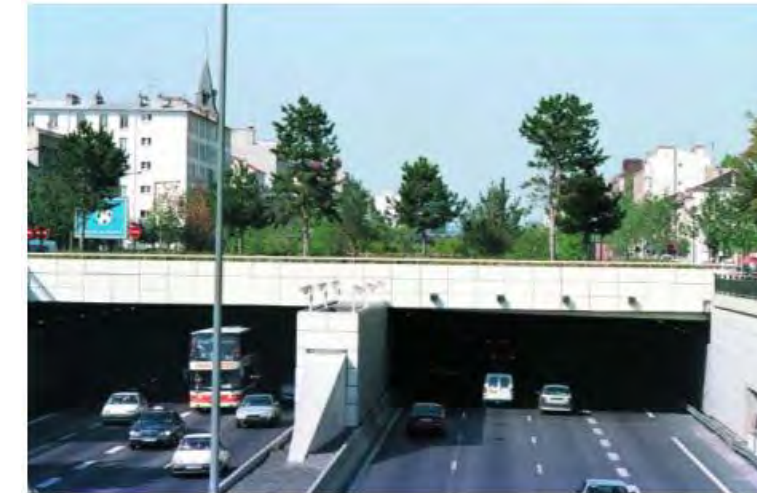
Figure 21 : Exemple de tranchée couverte (source : IQOA Tranchées couvertes, SETRA, mars 2009)
