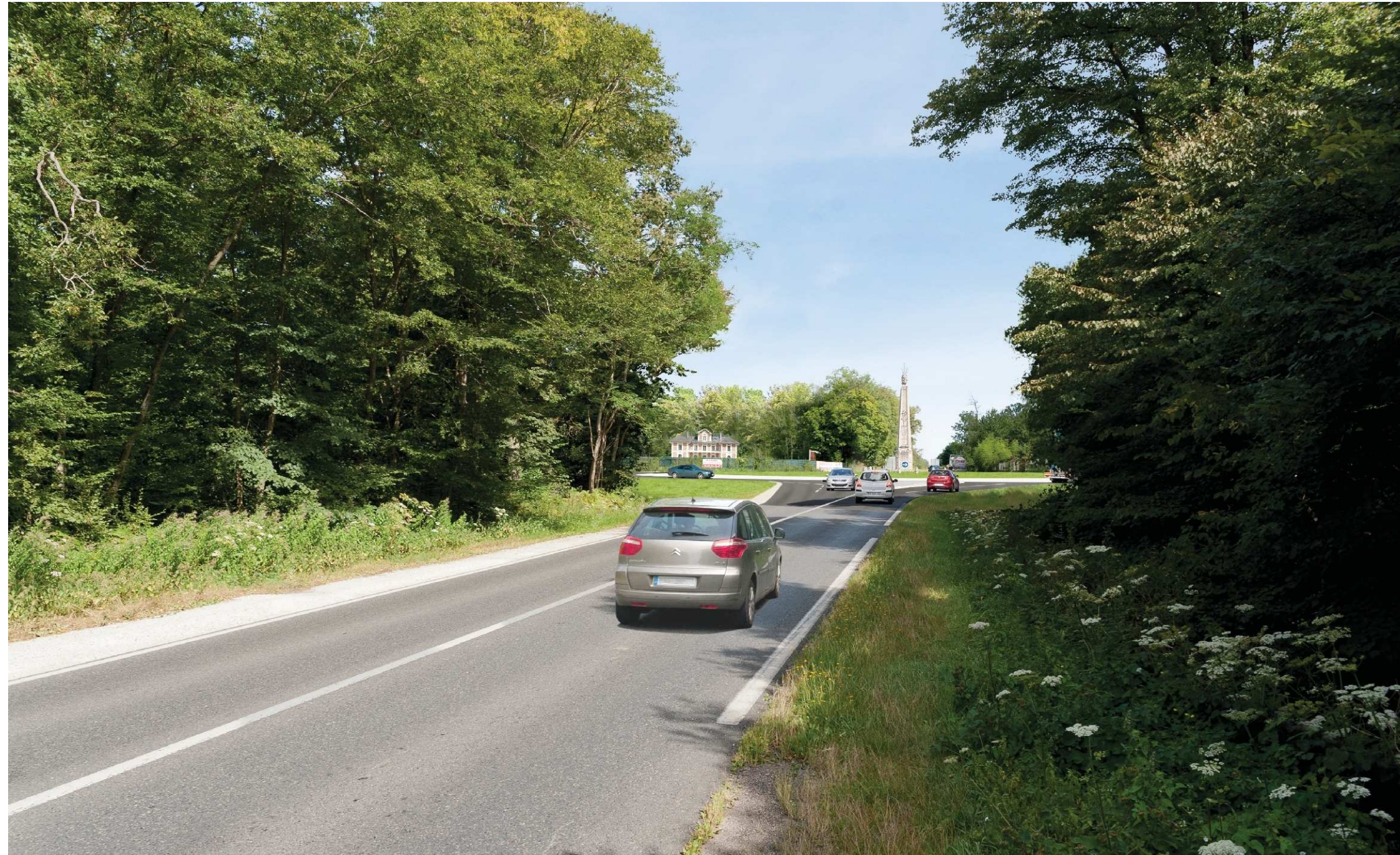
Vue de l'aménagement d'un giratoire de 45 m de rayon depuis la RN36 Sud
