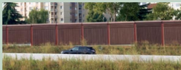
La protection acoustique est assurée par des écrans en « béton de caoutchouc ». Cette technique, à base de recyclage de matériaux, donne aux ouvrages la texture nécessaire à maximiser leur pouvoir absorbant. L'amortissement réel des bruits de la circulation automobile sera mesuré pour vérifier l'efficacité du dispositif.
