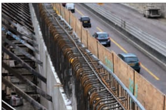
Corbeaux supportant les poutres
