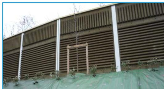
Deux écrans absorbants d'une hauteur maximale de 7 mètres et d'une longueur de 253 mètres pour l'un et 444 mètres pour l'autre seront implantés au sommet de la butte, le long de la rue Pasteur Vallery Radot
