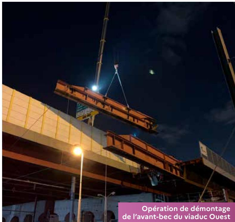
Opération de démontage de l'avant-bec du viaduc Ouest
