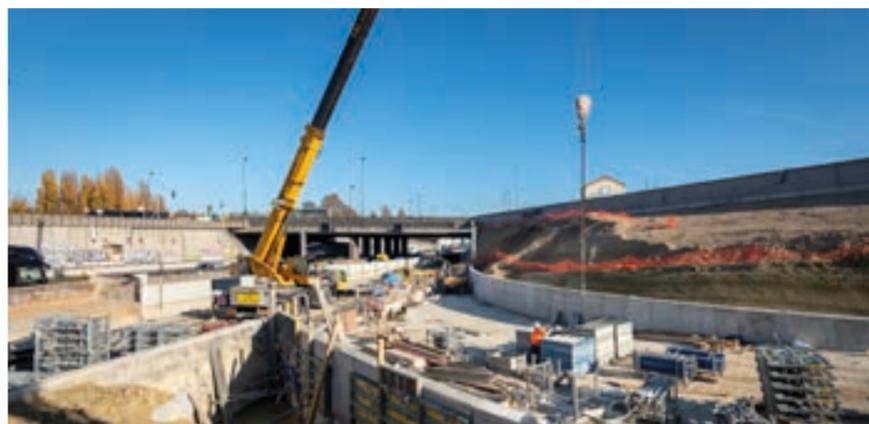
Avant la pose de l'enrobé, il faut en effet réaliser les différentes couches inférieures, qui constituent la structure de la future route. Une fois la couche d'enrobé posée, et avant de pouvoir mettre en service la voie, les marquages routiers et la pose de la signalisation et du mobilier urbain devront être réalisés.
