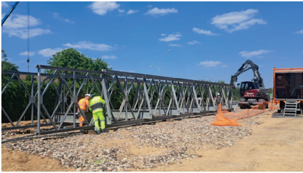
Mise en place de la passerelle piétonne
