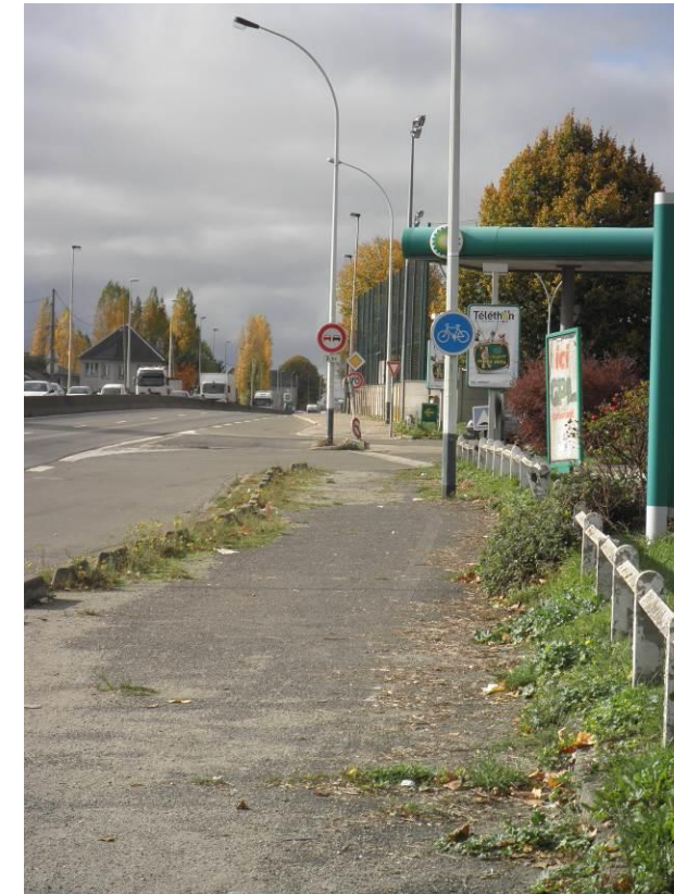
Photo 4 : Cheminement cyclable peu lisible et peu sécurisé le long de la RN 10 (sens Paris – Province en rive Nord à l'Ouest de la RD 23)
