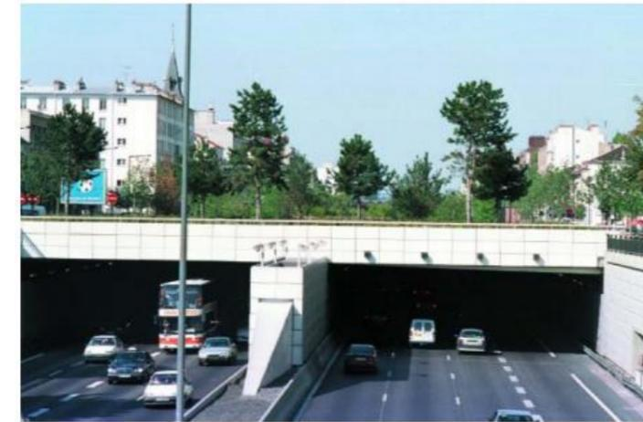
Figure 3 : Exemple de tranchée couverte (source : IQOA Tranchées couvertes, SETRA, mars 2009)
